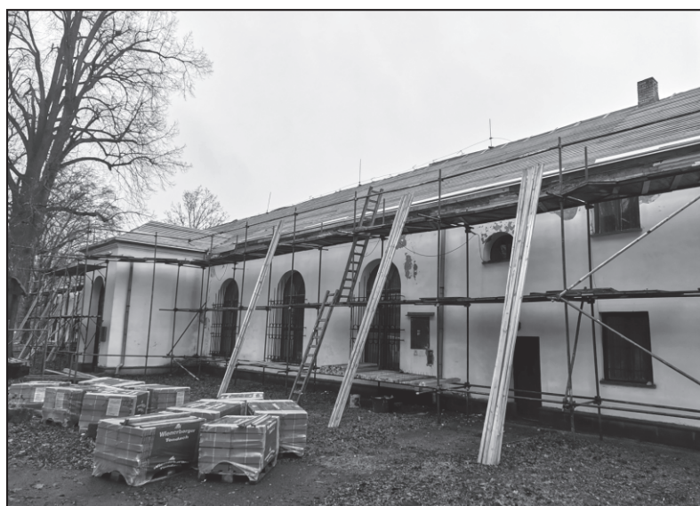
Prebiehajúce rekonštrukčné práce na objekte strechy koniarne
