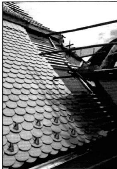
Oprava krovu a výmena strešnej krytiny – pálenej škridly
