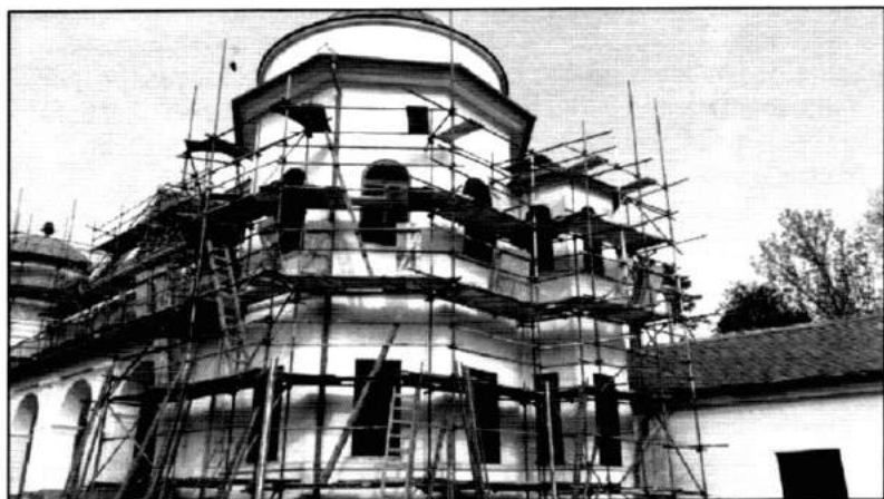
Hlavná budova kaštieľa počas rekonštrukcie
