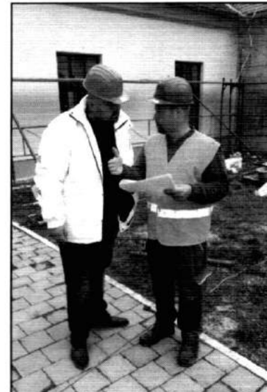
Momentka z rekonštrukčných prác
